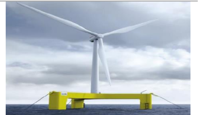
그림 13. 해상풍력 부유식 하부구조물(Tri-Floater)
